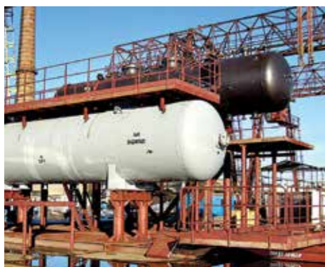
Установка предварительного сброса воды УПСВ-6000, ЯНАО
