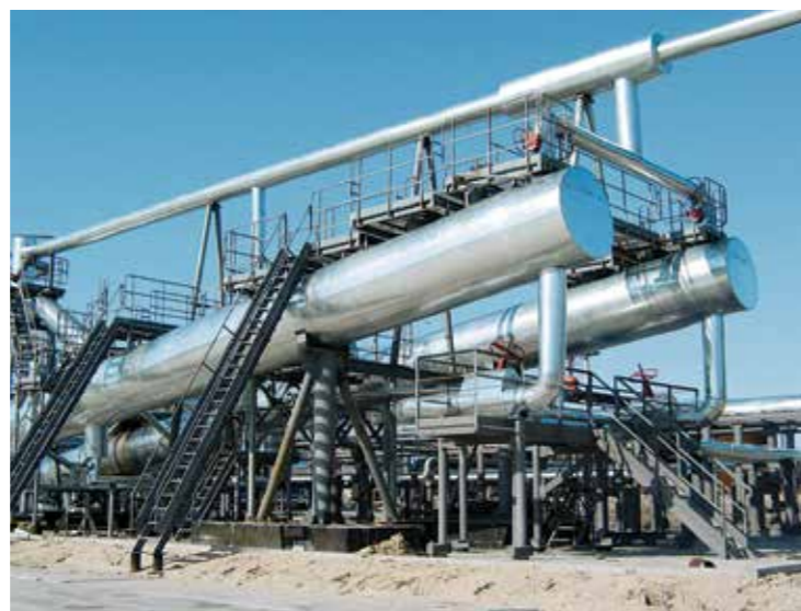
Концевой делитель фаз трубный КДФТ, Тюменская область, ХМАО
