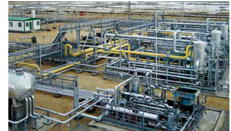
Установка подготовки природного газа на месторождении Каламкас, Казахстан
