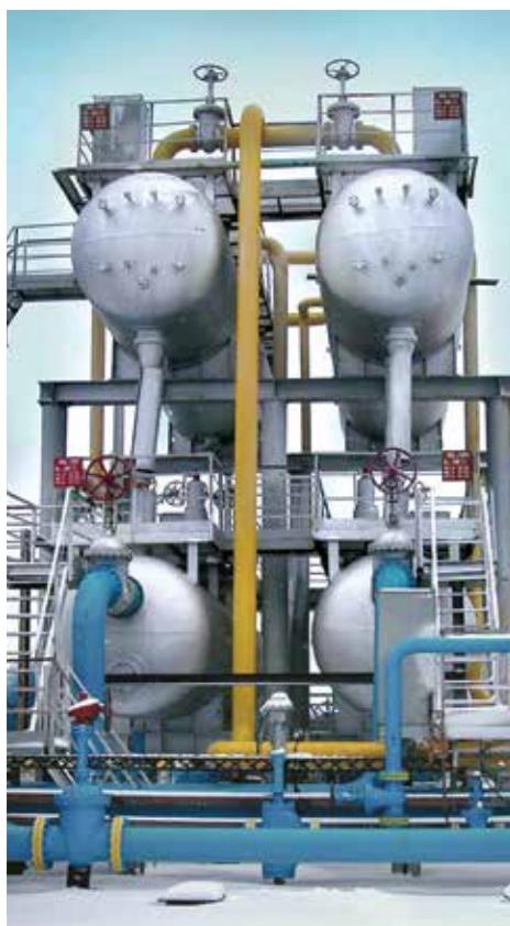
Установка предварительного сброса воды УПСВ Тюменская область, ХМАО
