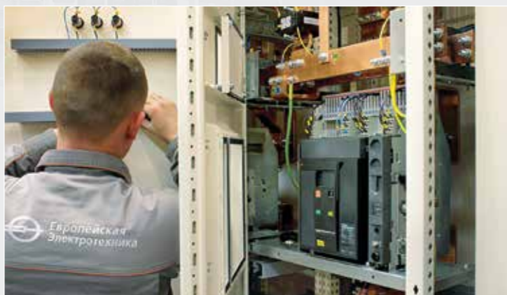
Производство электрощитового оборудования
